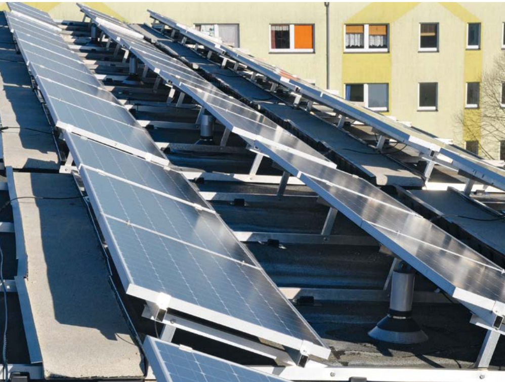
Überbaute Absturzsicherungen, kein Schutzlage, laienhaft ausgeführte Auflast des PV-Ständerwerks. Auch im abgebildeten Fall handelten die Monteure ohne Sachverstand.
