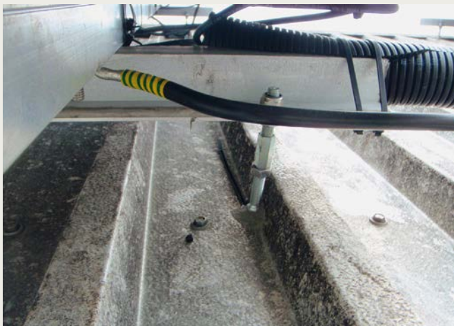
Eine Stockschraube in der Sicke eines Aluminium-Trapezblechdaches – abgedichtet mit Silikon. Kurz nach der Montage der PV-Anlage auf einem Industriedach traten die ersten Undichtigkeiten auf.
